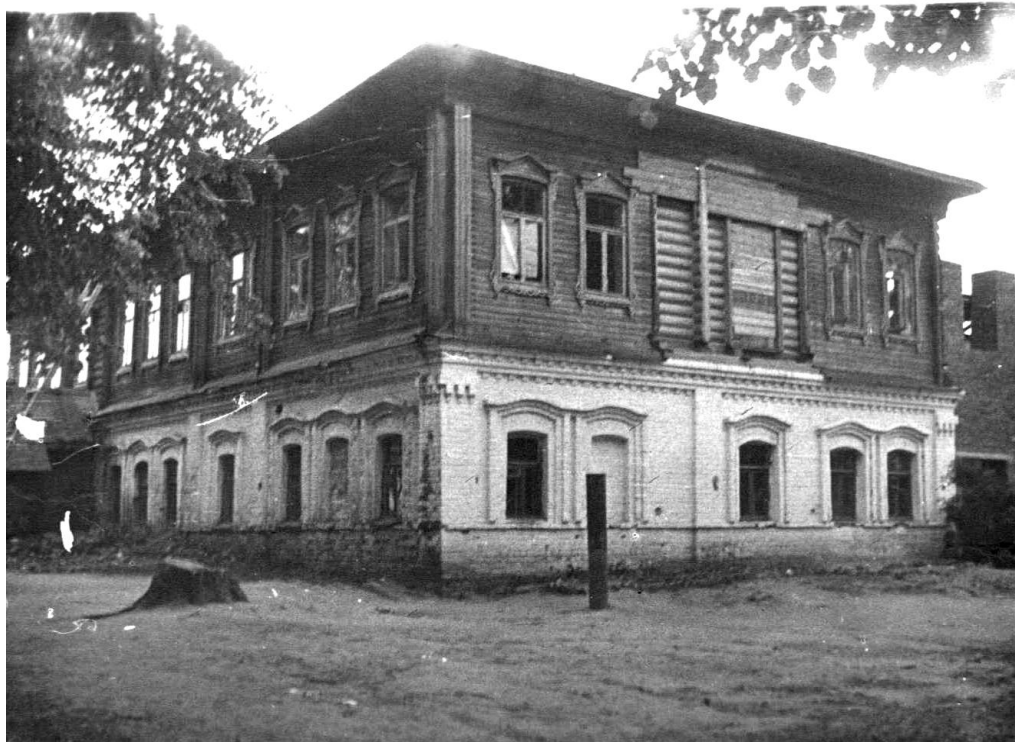
Начало реконструкции старого здания – заложены балконные окна, начато строительство кирпичной пристройки. 1962 г.
